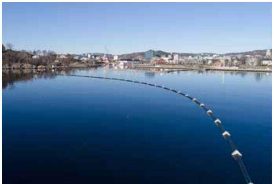
Agder Energi Varme utvider fjernkjølenettet slik at flere bygg i Kristiansand sentrum kan kjøles ned med sjøvann fra dypet av Byfjorden. (Foto: Håvard Anthonsen, Fundament).
