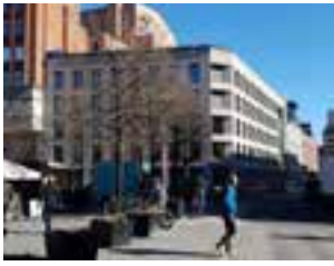
Youngstorget 3 i Oslo er landets første næringsbygg med sorptiv kjøling basert på fjernvarme.
